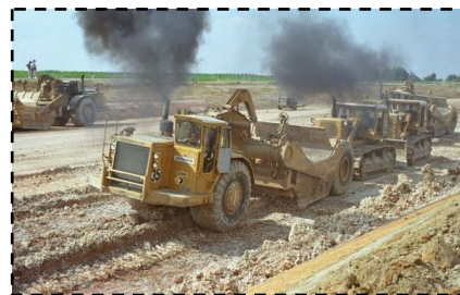
Chantier LGV Tours-Bordeaux
